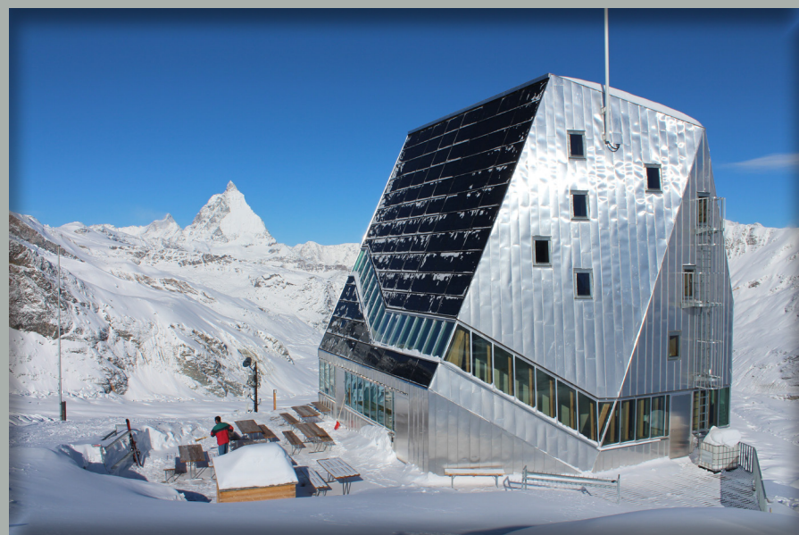
Monterosa Hütte / Sanierung Fassade
